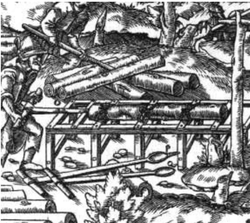
Der Teuchelbohrer wurde von Hand geführt um eine Höhlung von ca. sieben Centimeter Durchmesser auszubohren. Die einzelnen Leitungsteilstücke wurden durch verschiedene Techniken miteinander verbunden. Bild aus "Berg- und Hüttenwesen" (*De re metallica*) von Georg Bauer, 1494 in Glauchau geboren. Agricola "Bauer", genannt.
