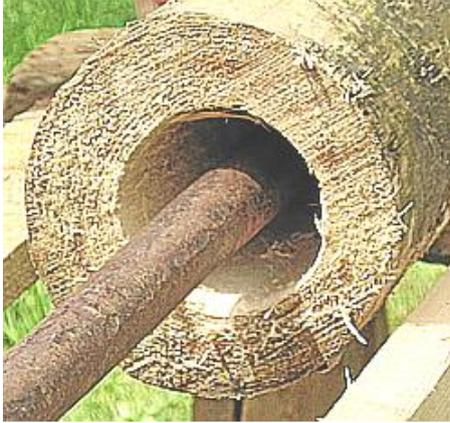
Das Wasser wurde über einer solchen "Teuchelleitung" (Deichel, Holzleitung) zu den Brunnen geführt. Die Holzleitung wurde, mit Hilfe eines mehreren Meter langen Holzbohrers, stirnseitig gebohrt und am Ende mit einer eisernen Rohrkupplung (Zwinge, Muffe oder Teuchelring) versehen. Geeignete Holzarten waren Weiss- und Rottanne.
